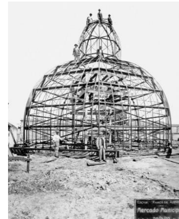
Figura 66: Construção da estrutura de uma das abóbodas do edifício. Disponível em: https://arquivo.arq.br/projetos/mercado-municipal-de-sao-paulo#gid=1&pid=6 . Acesso em: dez. 2022.
