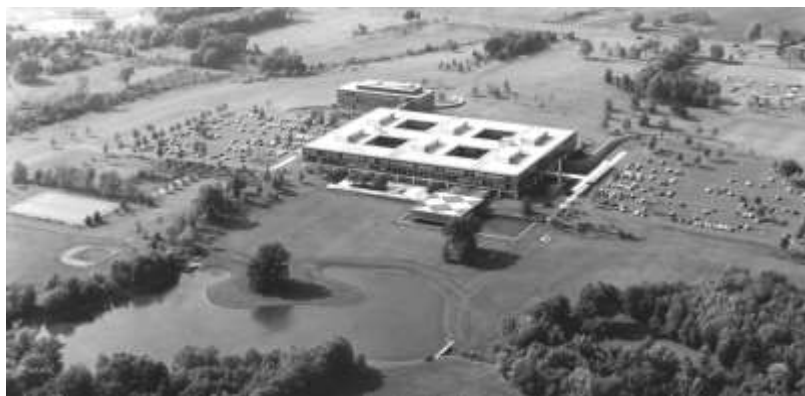
Figura 1.10. Imagem aérea das instalações da Connecticut General do escritório de arquitetura SOM. Fotógrafo Esto. Disponível em: https://tinyurl.com/yet8n4zm . Acesso em 10/07/2023.
