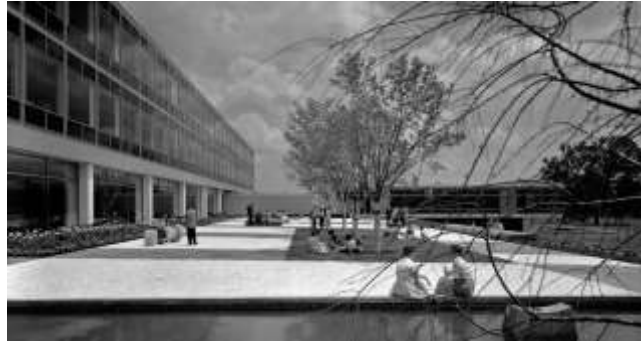
Figura 1.11. Imagem do pátio externo da Connecticut General do escritório de arquitetura SOM. Fotógrafo Esto. Disponível em: https://tinyurl.com/ye8n4zm . Acesso em 10/07/2023.
