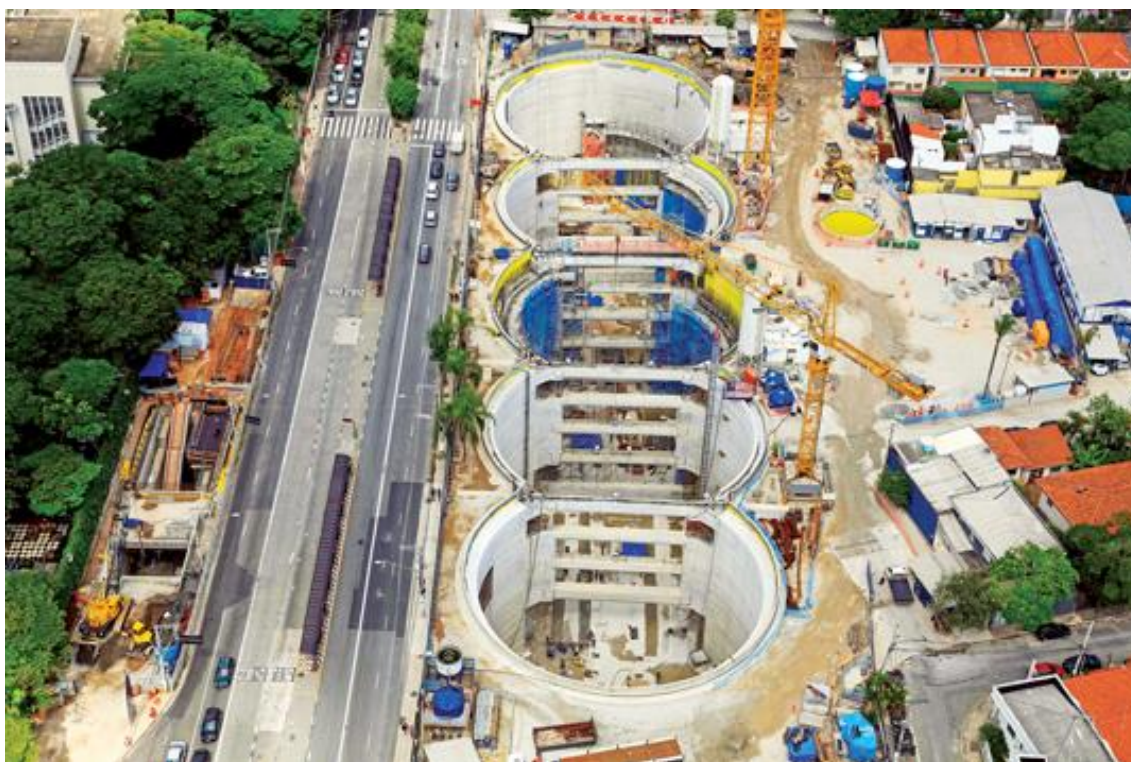
Figura 12: Túneis verticais, os chamados “poços”, presentes na obra da Estação Brooklin.
