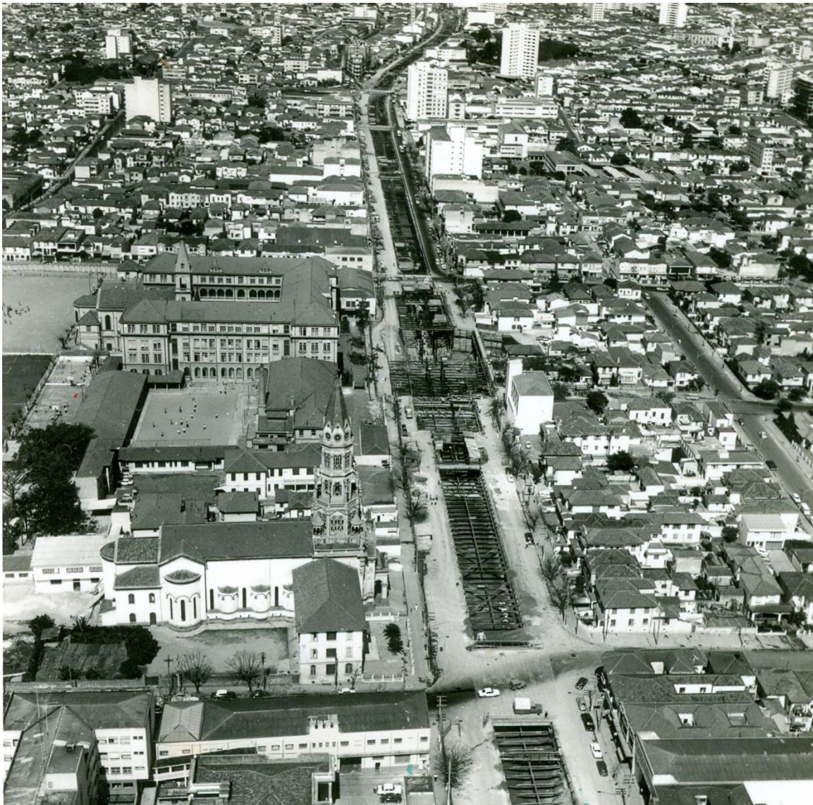
Figura 27 - Obras civis Trecho 7 - Estações: Santa Cruz e Praça da Árvore da Linha 1-Azul na década de 1970.
