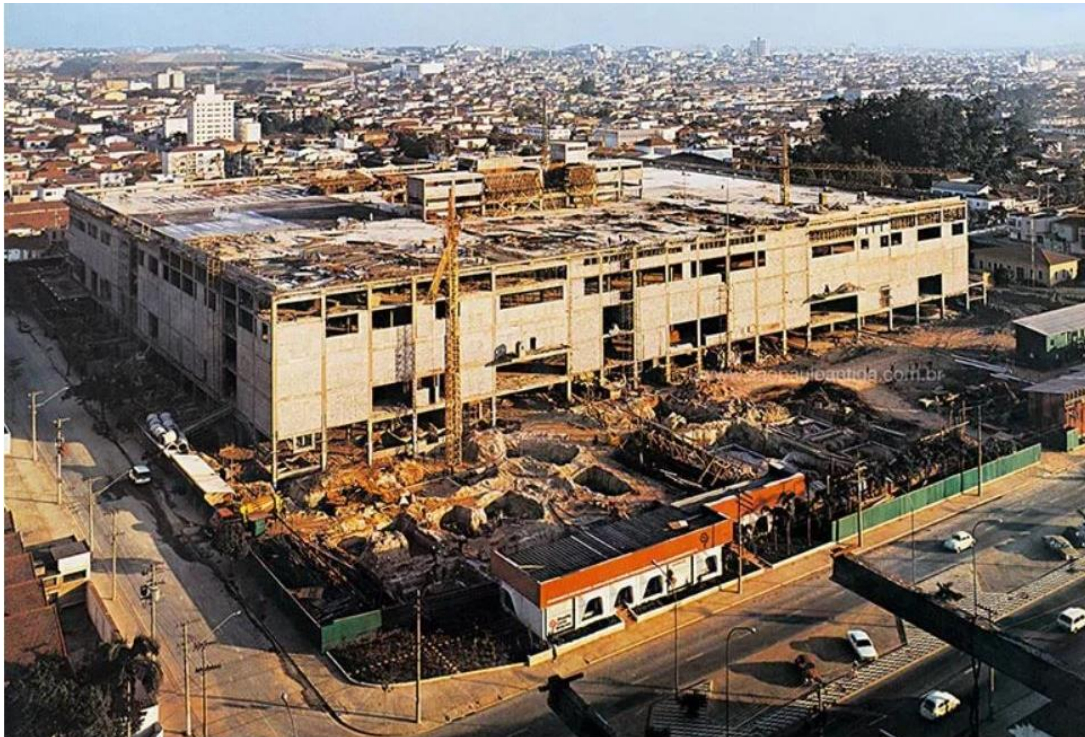
Figura 54 - Obras do Shopping Ibirapuera em meados de 1975.
