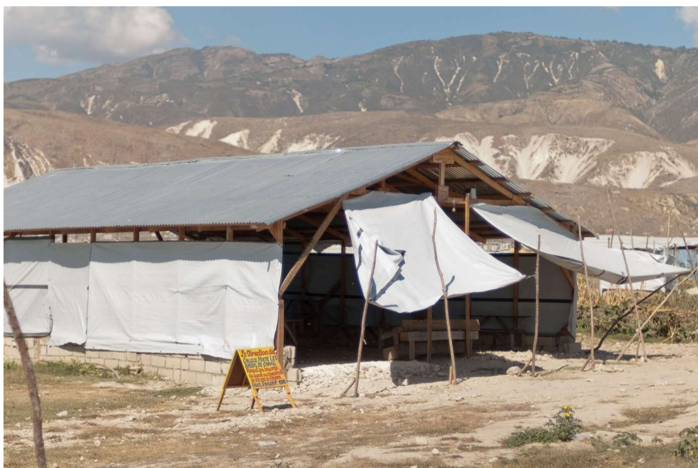
Figura 01 – Escola privada de ensino fundamental localizada no assentamento de Canaan, no subúrbio de Croix-des-Bouquets e Thomazeau, nos arredores de Porto Príncipe, Haiti. (2011)
