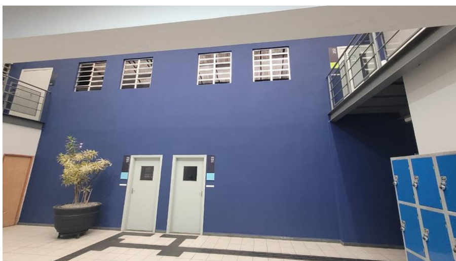
Pintura das Paredes do Prédio Veredas 1
