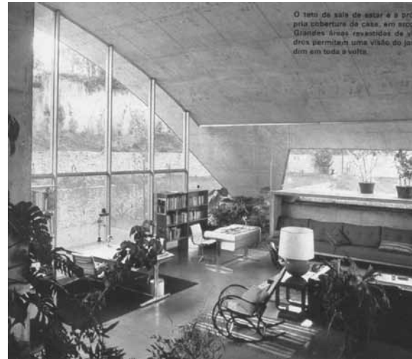
Figura 5 - Vista interna- detalhe dos caixilhos realizados com o mesmo sistema usando perfis metálicos, Casa Marlene Milan Acayaba, Arquiteto: Rodrigo Lefevre, data: 1964, local: Morumbi, São Paulo-SP, construtora CENPLA. Fonte da imagem: ACAYABA, Marlene M. - Residências em São Paulo 1947 - 1975, Projeto, São Paulo, 1986.
