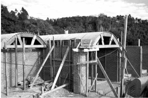
Figura 3 - Vista da cobertura da sede da Fazenda Veneza. Sistema em abóbadas de tijolos. Arquiteto: Décio Tozzi, data: 1973- 1976, local: Valinhos-SP, Construtora CENPLA. Fonte da imagem: Acervo construtora CENPLA
