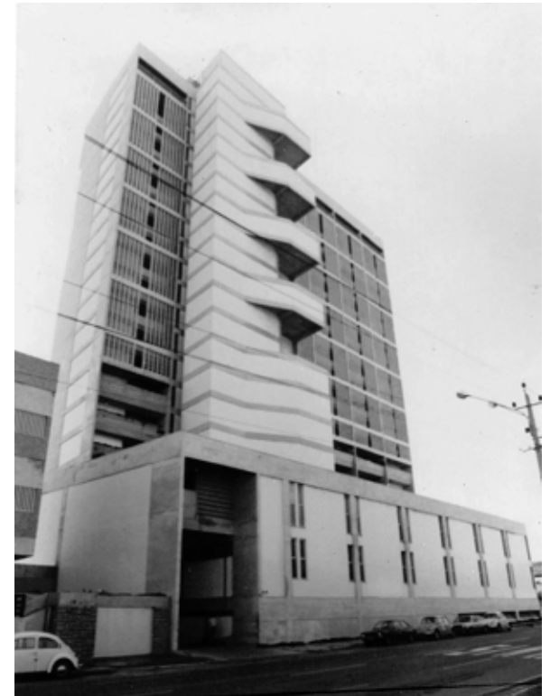
Figura 09 – Foto fachada sul Hotel Esplanada. Fonte: Diógenes, Cartaxo, Montenegro, 1983.
