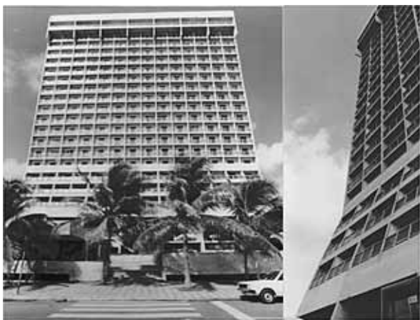
Figura 02 – Foto da fachada norte Hotel Esplanada. Fonte: Diógenes, Cartaxo, Montenegro, 1983.
