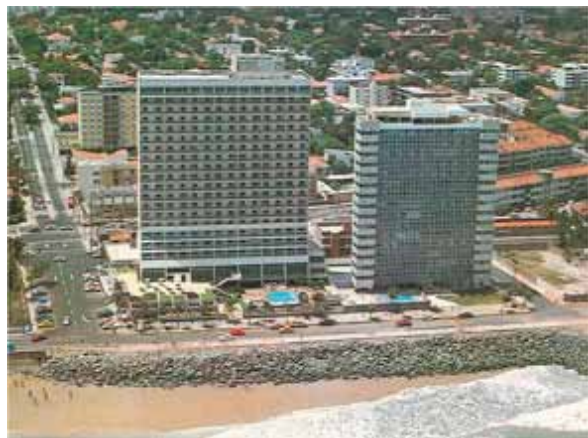
Figura 01 – Vista aérea Hotel Esplanada. Fonte: SOUZA, 2015.
