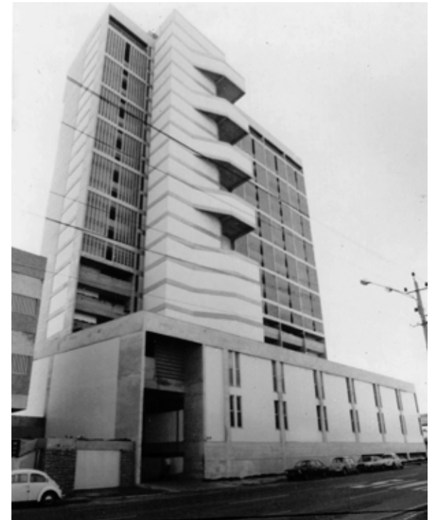
Figura 09 – Foto fachada sul Hotel Esplanada. Fonte: Diógenes, Cartaxo, Montenegro, 1983.
