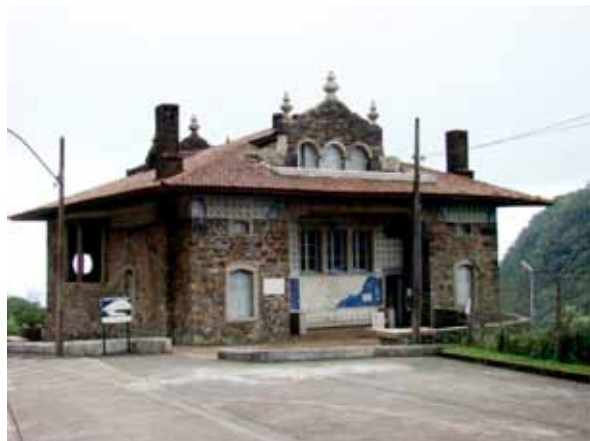
Figura 1. Pouso de Paranapiacaba. Fonte: https://geolocation.ws/v/P/33913242/casaro-pouso-paranapiacaba-na-estrada/en
