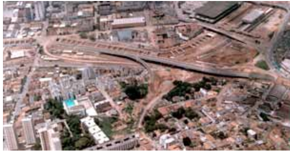
Figura 03. Construção do Complexo Viário da Lagoinha em 1984. Fonte: Acervo Mascarenhas Barbosa Roscoe.
