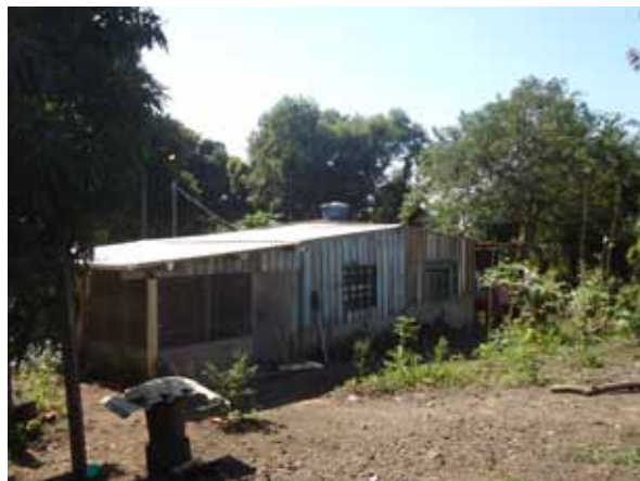
Figura 04. Tipologia de casa de madeira encontrada no povoado, térrea avarandada (fechada), com telhado de pouca inclinação e construída em madeira. Foto: Vinicius Martins de Oliveira (2016).
