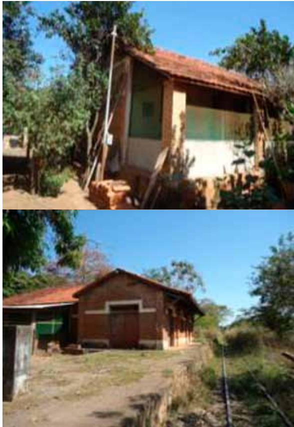
Figura 17 /e18. Tipologia típica de casa de ferroviário, apresenta tijolos aparentes e fachada avarandada, construída em alvenaria com telhado cerâmico, mantém o uso residencial. Antiga estação ferroviária. Foto: Vinicius Martins de Oliveira (2016).
