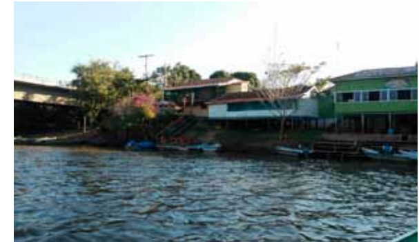
Figura 09 e 10. Vista de um conjunto de casas sobre palafitas, típica de ribeirinhos, percebe-se a estrutura que eleva o imóvel com o intuito de buscar refúgio em períodos de cheia, o emprego da madeira e a tipologia que preza a funcionalidade, a quantidade de barcos encostados sugere que ali se encontra um grupo grande de pescadores. Edificações ribeirinhas convertidas em pousadas, relatadas pelos moradores como grande atrativo para os turistas que vem passar temporadas na região enquanto pescam. Foto: Vinicius Martins de Oliveira (2016).
