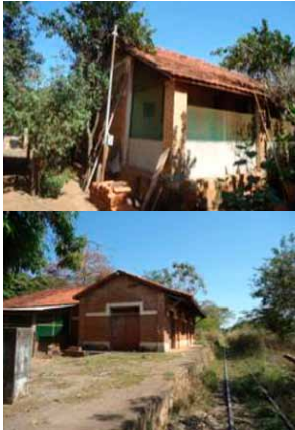
Figura 17 /e18. Tipologia típica de casa de ferroviário, apresenta tijolos aparentes e fachada avarandada, construída em alvenaria com telhado cerâmico, mantém o uso residencial. Antiga estação ferroviária. Foto: Vinicius Martins de Oliveira (2016).
