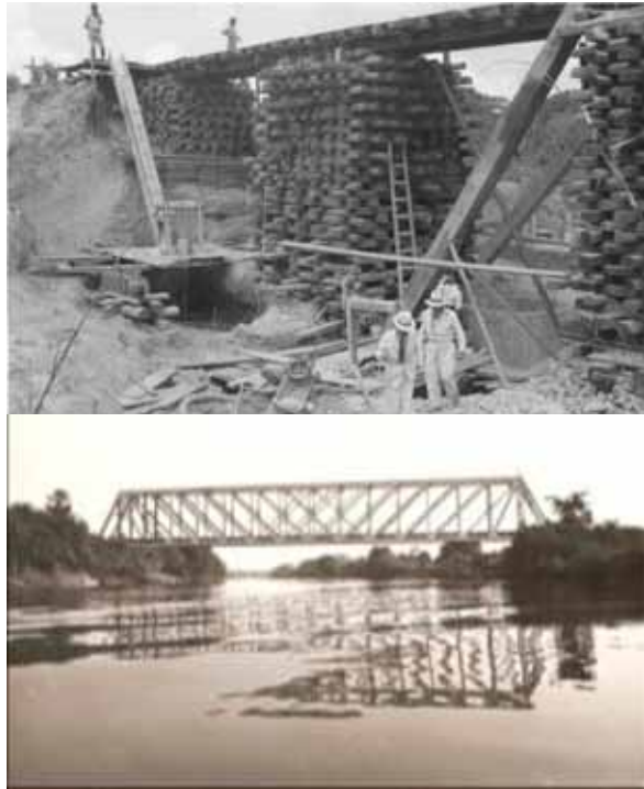
Figura 11 e 12. Fotos históricas, homens trabalhando durante a construção da ponte em meados dos anos 1920. Vista da estrutura recém inaugurada. Sem data. Fotos: Autores desconhecidos.
