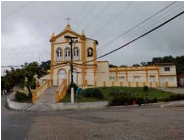
Figuras 32: Igreja de Fernão Velho – AL. Fonte: Visita técnica IPHAN - AL, 2016.
