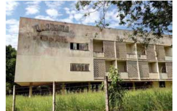
Figura 4: Ruínas do Hotel Umuarama, em Ribeirão Preto. Projeto da década de 1960, do engenheiro Hélio Fóz Jordão. Exemplar modernista abandonado. Fonte: Acervo de Larissa França Peres (12/2013).
