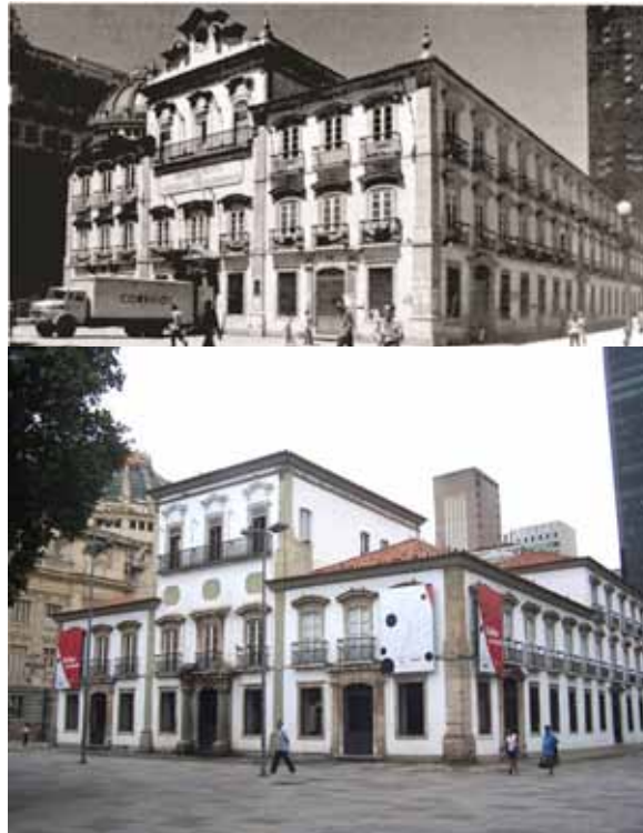
Figuras 2 (acima) e 3 (abaixo). Paço Imperial, Rio de Janeiro, década de 1980, antes e depois das obras de restauro. Fontes: Figura 2 – Revista do Patrimônio, nº 20, pp. 141, apud CUNHA, 2010, p.119/ Figura 3 – Disponível em: < https://pt.wikipedia.org/wiki/Pa%C3%A7o_Imperial > Acesso em: 11 out. 2016.
