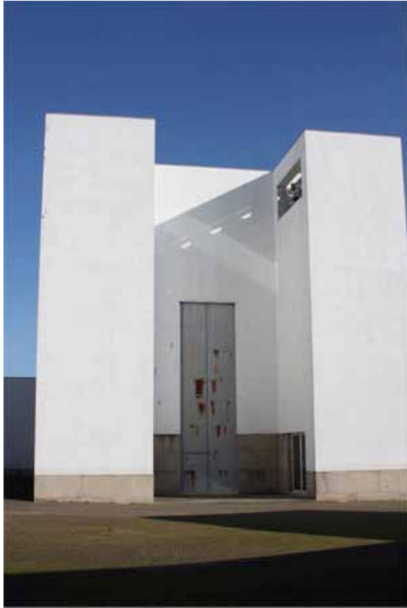
Figura 8 – Igreja de Santa Maria, Marco de Canaveses (Arq. Álvaro Siza). Fotografia de Teresa Dias Costa. No exterior, o edifício retoma alguns elementos da arquitectura tradicional de igrejas, como as torres sineiras ou a porta principal alinhada com o altar.
